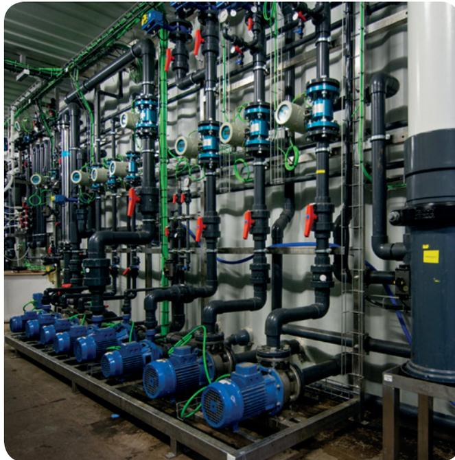
**Operación y montaje de prototipos a escala piloto** que incluyen y combinan procesos biológicos con tecnologías de membranas, materiales adsorbentes y procesos de oxidación avanzada (ozonización, desinfección UV y peróxido).
