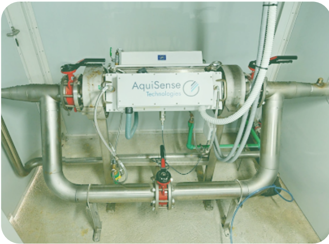
Imagen 3. Lámpara UV usada en la planta piloto de LIFE WARRIOR.
