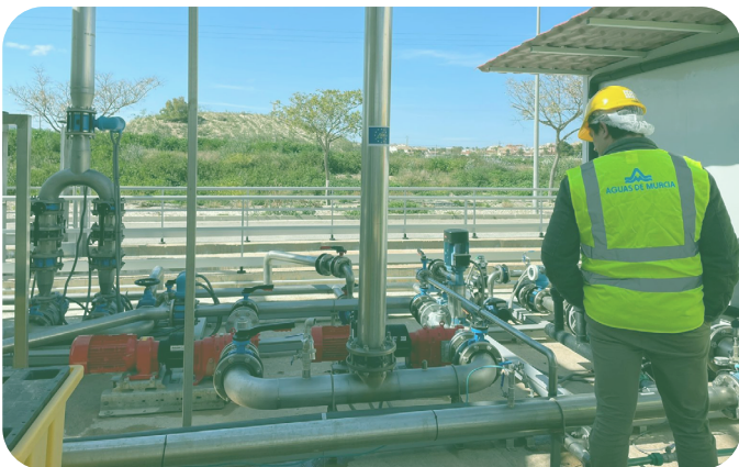
Imagen 6. Detalles del sistema de membranas de UF reutilizadas de la planta piloto LIFE WARRIOR.
